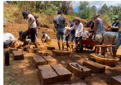
Figura 5. Realizando ladrillos de adobe (fotografías por Edna Silva Tovar)
