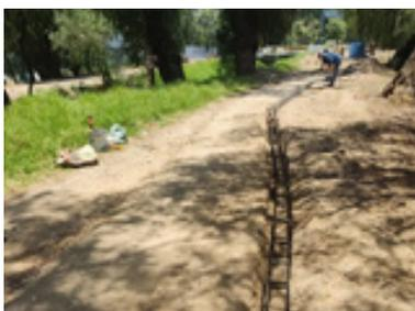
Ilustración 10. Excavación y armado para el colado de las guarniciones del andador peatonal.
