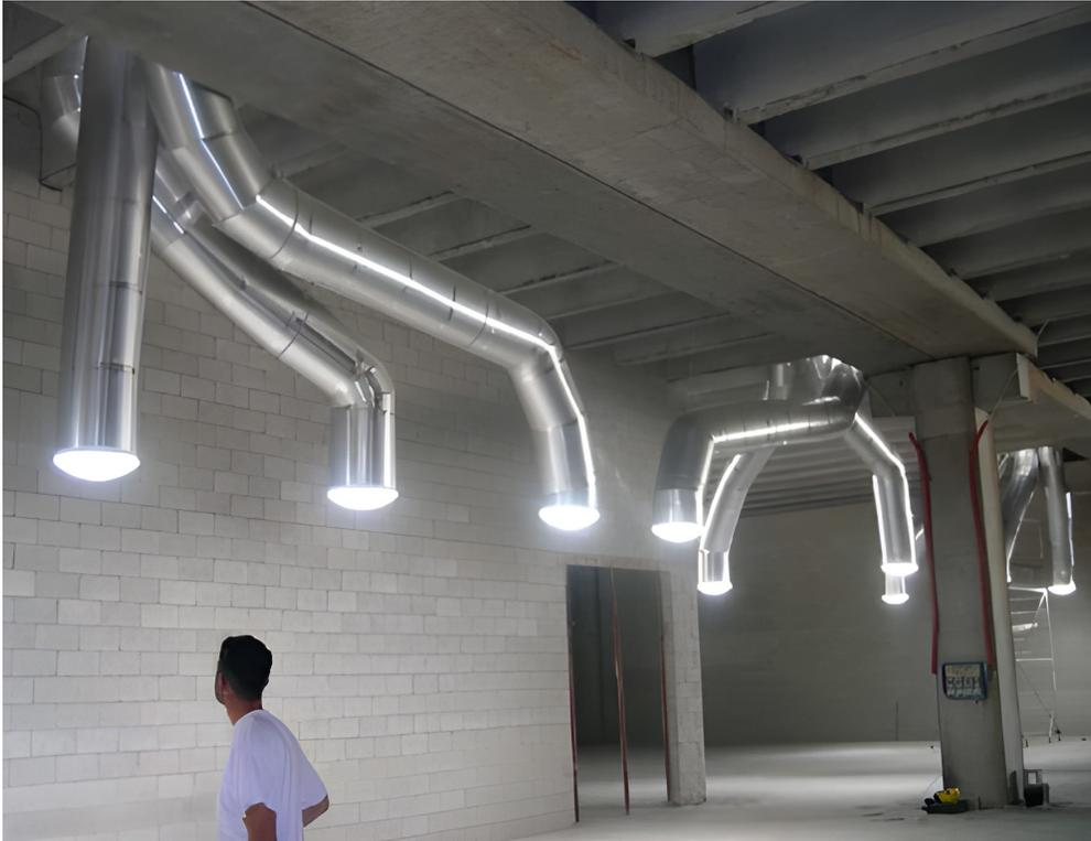
Imagen 6. Adaptador con salida triple, fuente <https://www.speaweb.it/soluzioni/luce-solare-naturale/>
